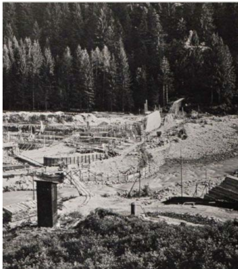
Cantiere I lavori di realizzazione della diga di Cornisello Archivio Fotografico Storico Provinciale di Trento©
