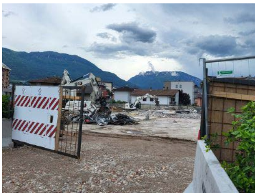
Lavori in corso L'area ex Mondini, anche vista dall'alto (sopra) © Foto Loss
